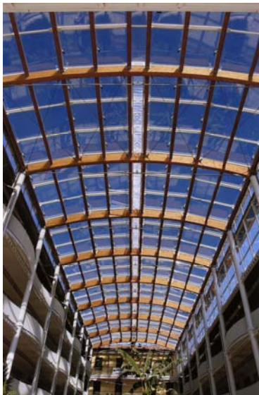
ATER DI PADOVA – CONTRATTO DI QUARTIERE SAVONAROLA GIARDINO D'INVERNO NELL'EDIFICIO "B" - INTERNI
